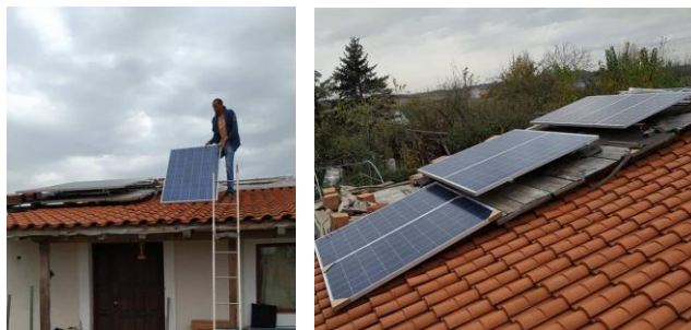
Primopredaja i ugradnja solarnih panela
